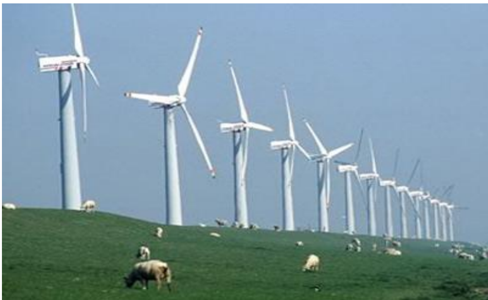
Hình 1.1: Một Wind farm trên đất liền gồm nhiều máy phát nối mạng với nhau
